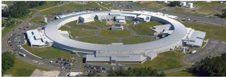
3GeV 放射光施設 NSLS-II Brookhaven国立研究所
